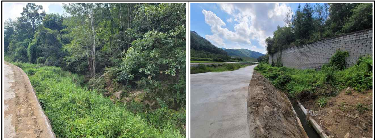
【사진 4.3.6】 지반, 기초부 전경
