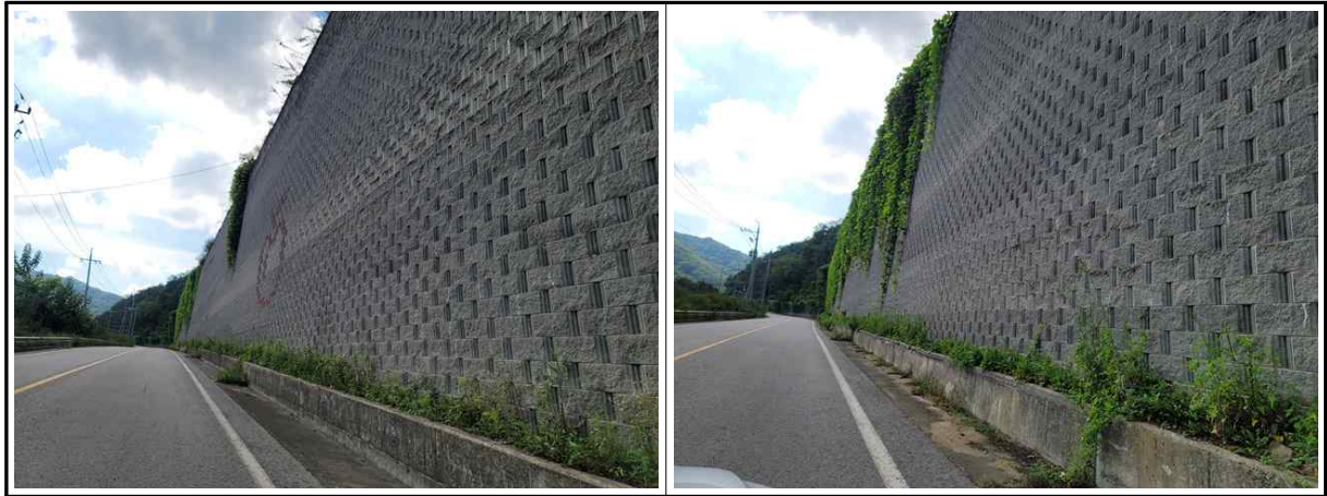
【사진 4.3.1】 지반, 기초부 전경
