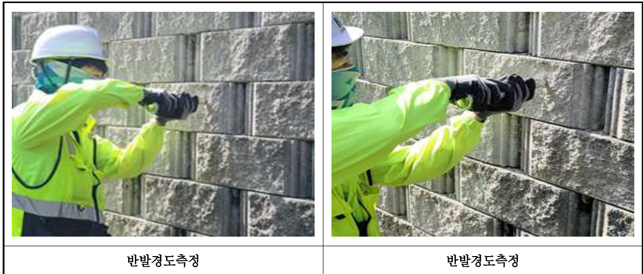
【사진 4.4.1】 재료시험 조사 전경
