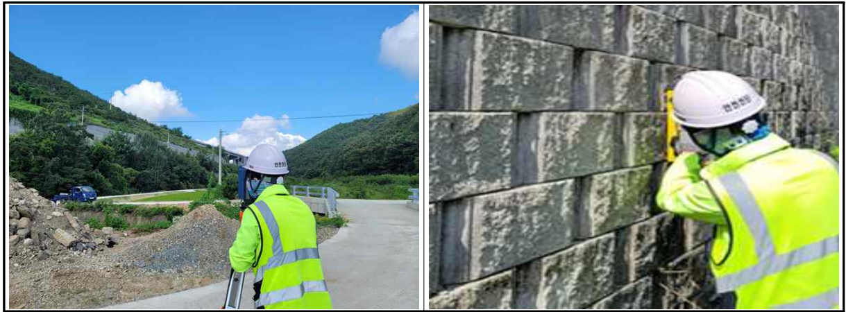
【사진 4.4.2】 측량작업 전경
